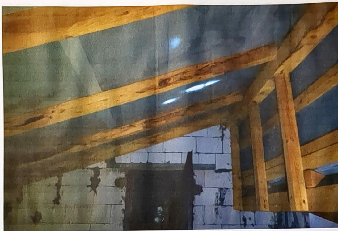
Obr.č.4: Ukázka poškození střešních šablon (průsvit světla v parozábraně) s následným zatékáním do konstrukce krovy a rozvojem dřevozbarvujících hub
