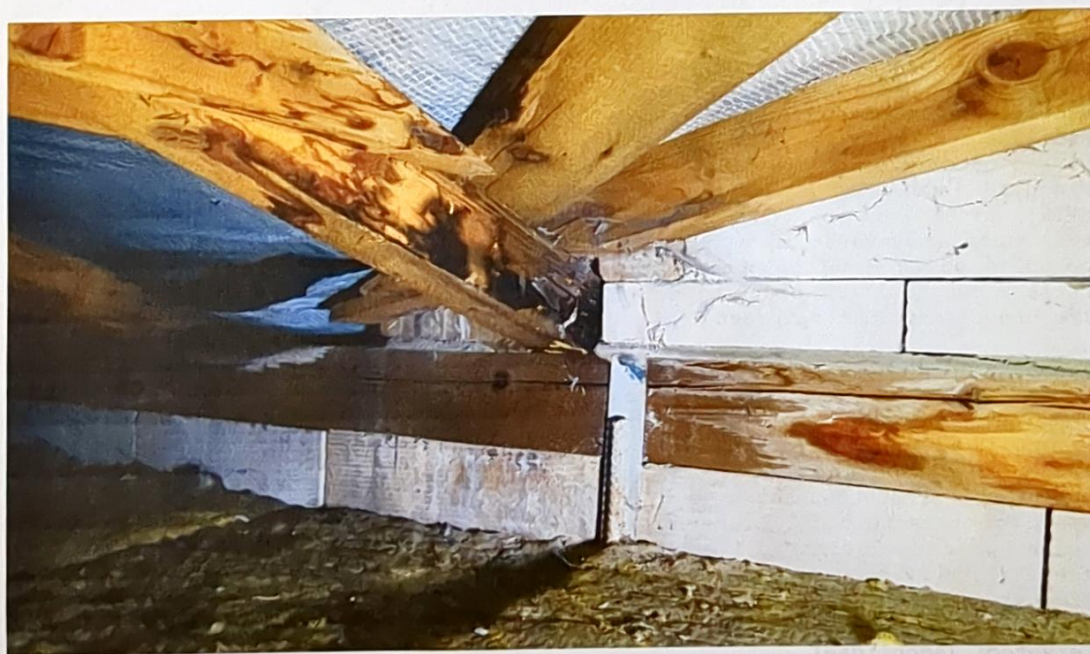
Obr.č.5: Ukázka rozvoje dřevozbarvujících hub na úžlabní krokvi
