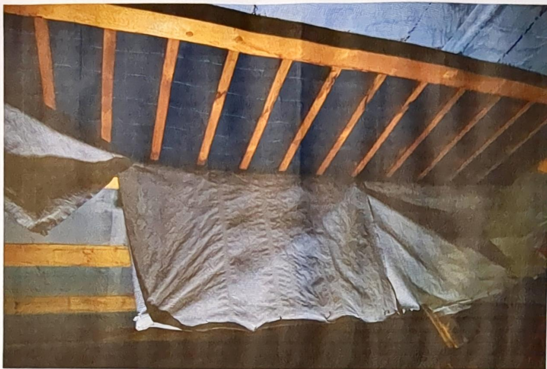
Obr.č.6: Ukázka poškození parozábrany. Na latích jsou patrné stopy po zatékání či kondenzaci vodních par z důvodu poškození střešního pláště nebo parozábrany
