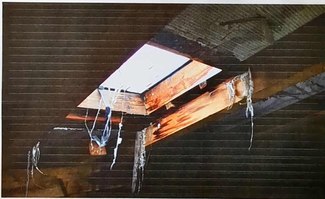
Obr.č.3: Ukázka projevu dřívějšího zatékání v okolí světlíku. Je patrný rozvoj dřevozbarvujících hub a poškození parozábrany.
